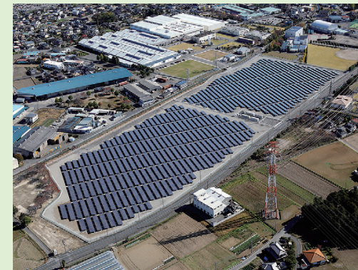
群馬工場跡地に設置されたソーラーパネル
